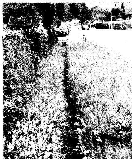
Die Entwässerungsgräben am Alten Berner Weg sind nur bedingt „schiffbar“
